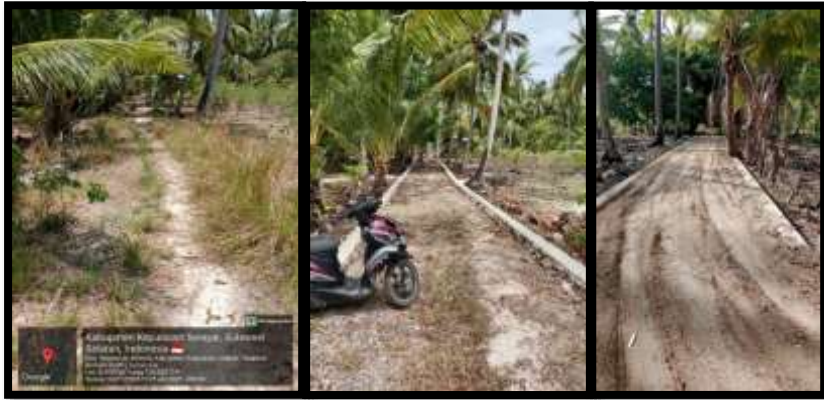
Gambar 31 Dokumentasi Pembangunan Jalan Usaha Tani Ruas Tana Eja – Buhung Timoro
