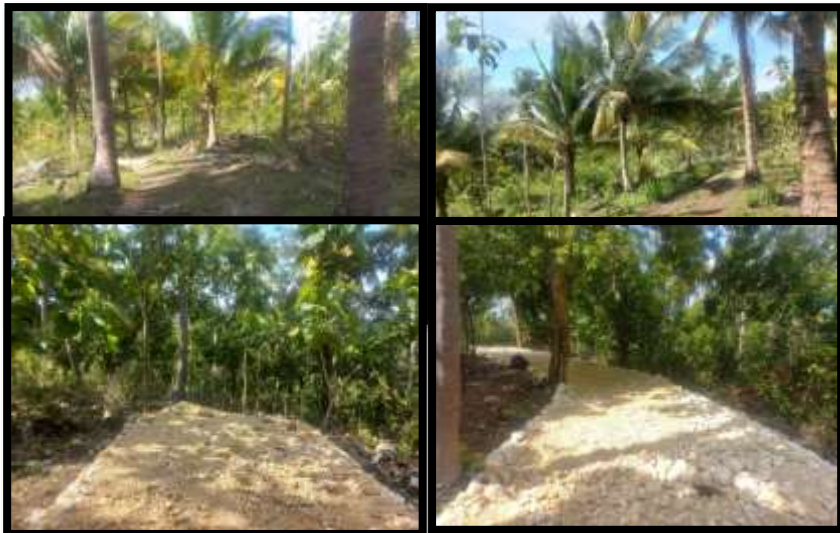
Gambar 35 Pembangunan Jalan Usaha Tani Ruas Kaburu – Katti – Katti
