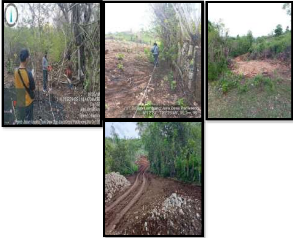
Gambar 34 Pembangunan Jalan Usaha Tani Dusun Lembang Jaya Desa Patilereng
